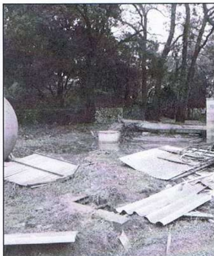
Après le passage de l'eau, il ne reste que des tôles froissées et de la boue.
